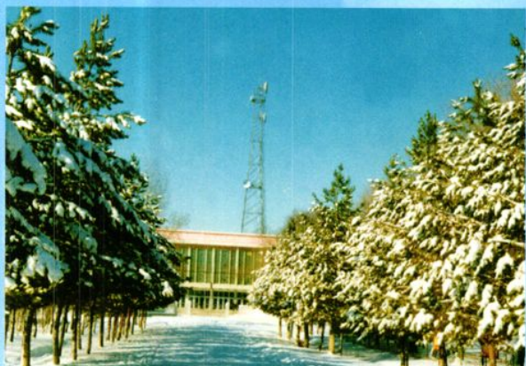
农场文化宫始建于1983年，建筑面积3600平方米。1992年10月，在文化宫西侧，安装了一座40米高的微波天线铁塔。
