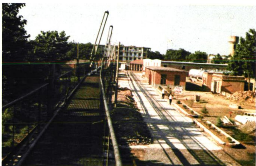
商丘石油站东油库
