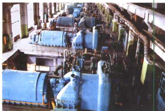
苇湖梁电厂旧机组
