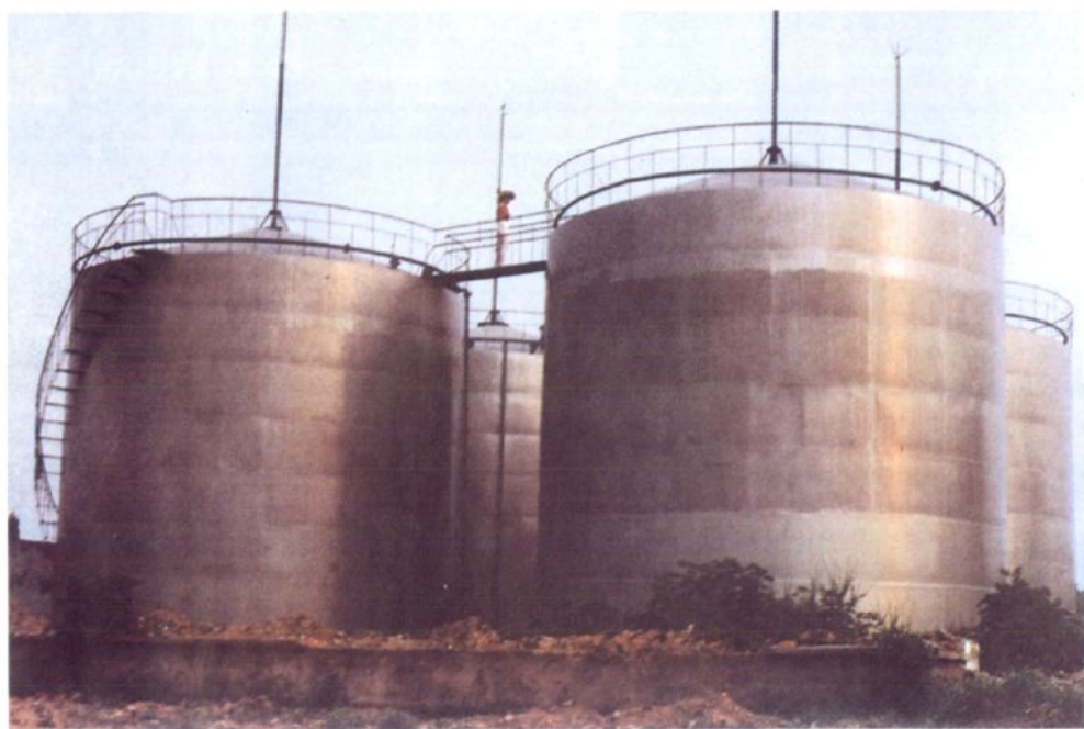
京运石油公司 2万吨的中心油库
