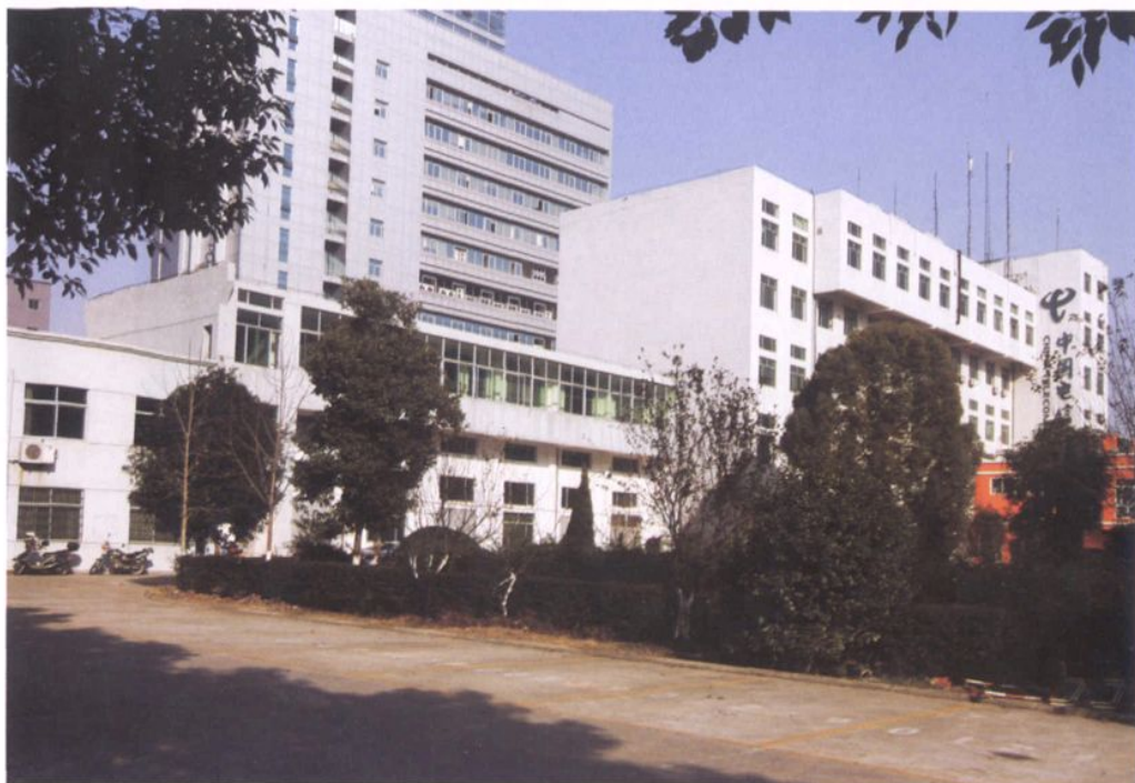
丽水地区局城东分局程控机房楼
