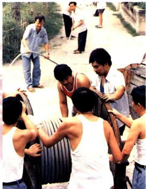
行管人员深入生产第一线敷设电缆
