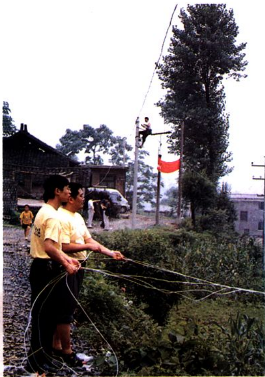
机线人员在架设市话线路
