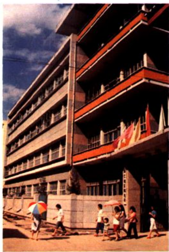
铜仁地区邮电局(电信综合大楼及局大门)
