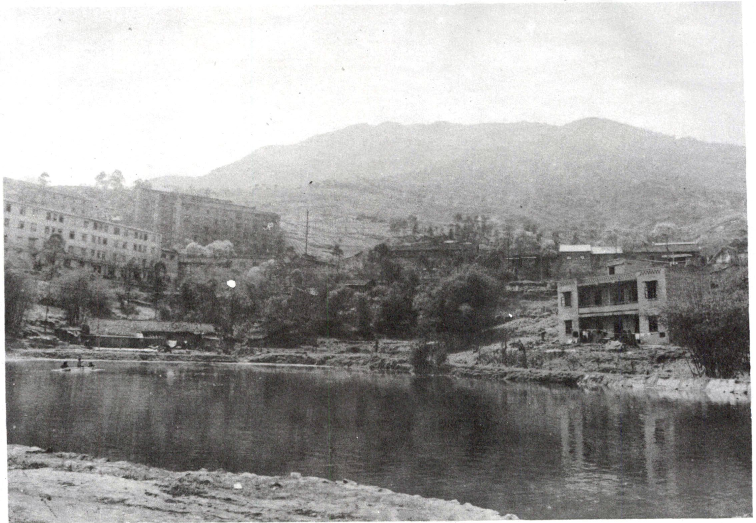
重庆钢管厂 I 生活区全貌
