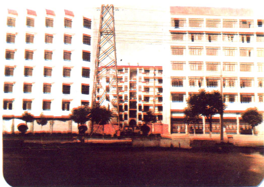
正在建设中的三明市交通大院
