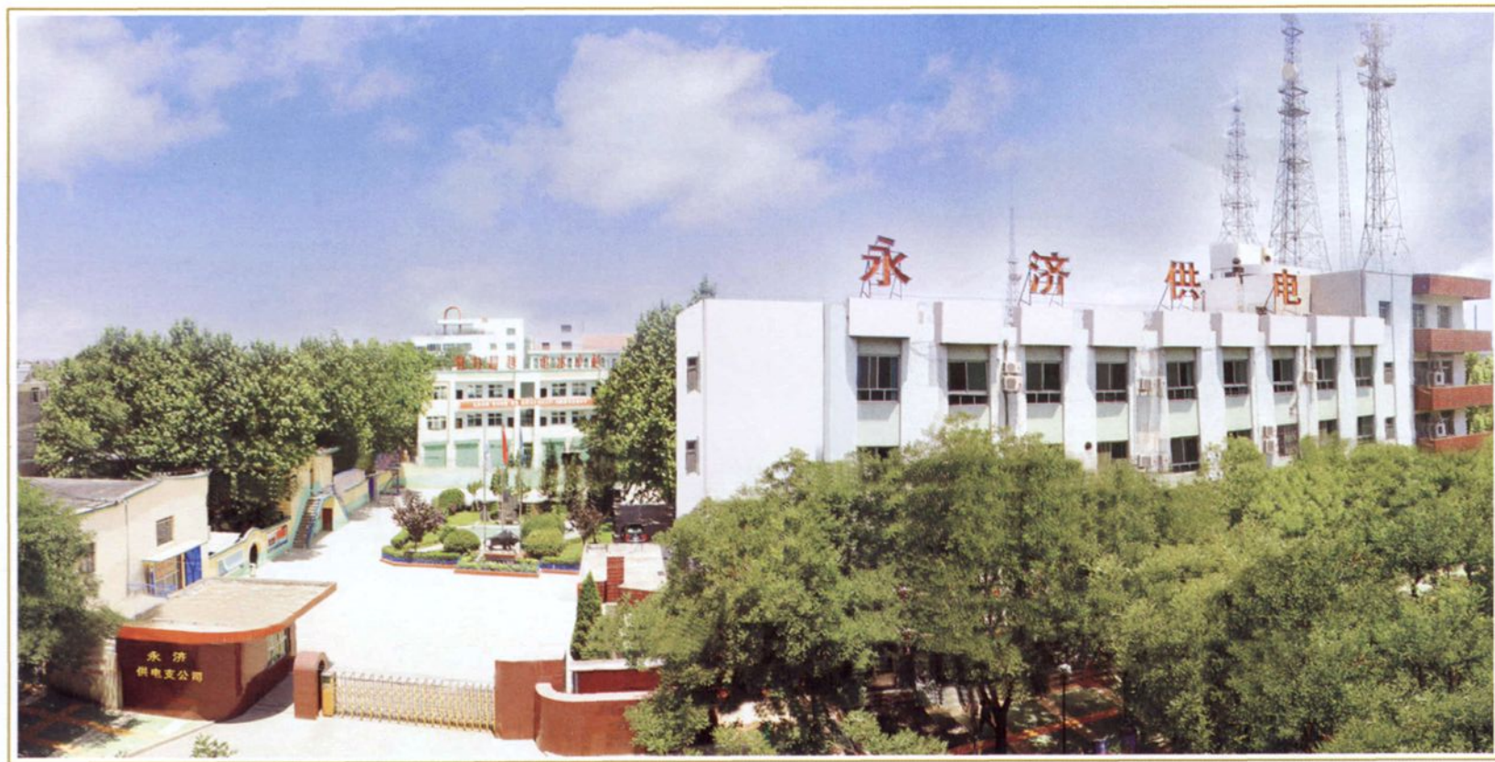
永济市供电局机关暨永济供电支公司本部（2005年）
