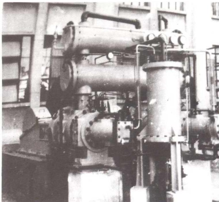
**23** 1958年10月,上海电机厂试制成功世界上第一台12000千瓦双水内冷汽轮发电机。
