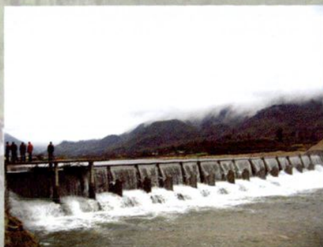
前溪河翻板闸
