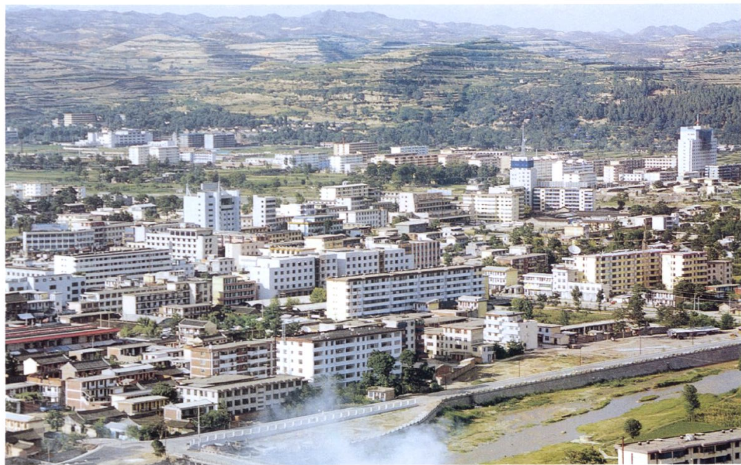
建设中的成县县城
