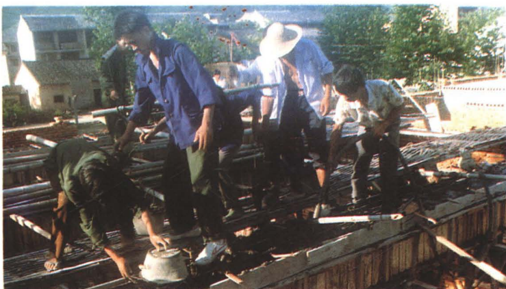
大田职技校建筑专业学生正在操作实习。
