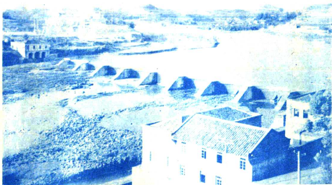
梓江左岸天仙“八一”水轮泵站
