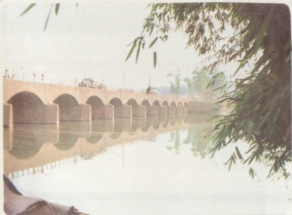
绵、璧公路要津，琼江诸桥之冠——大安大桥。
