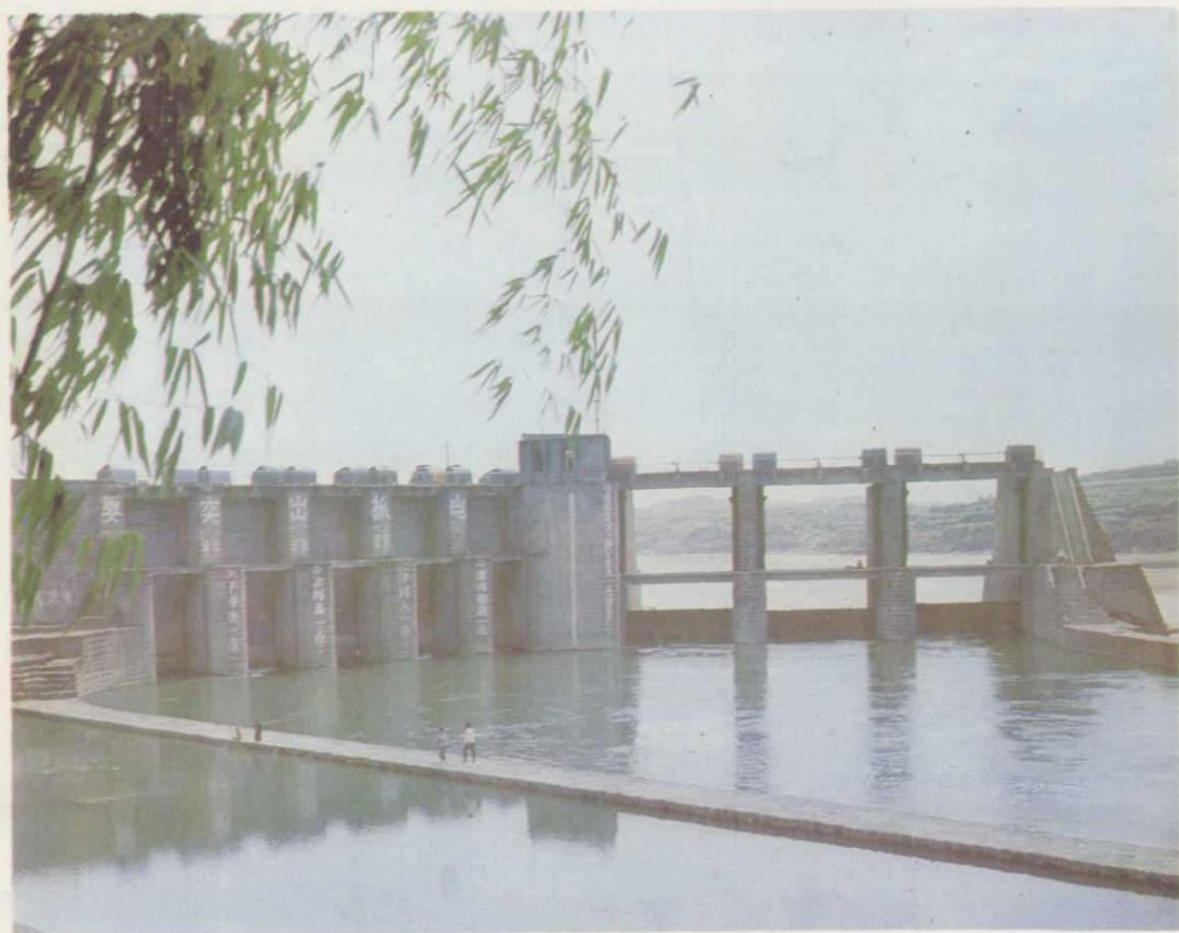
(4) 潼南水电站进水闸与防洪堤之一侧。
