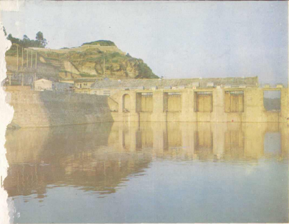
(1) 潼南水电站位于县城对岸东风公社东堂大队境内。1979年建成，装机容量1.28千瓦，年发电量1121.8万度。图为主产房之一角。
