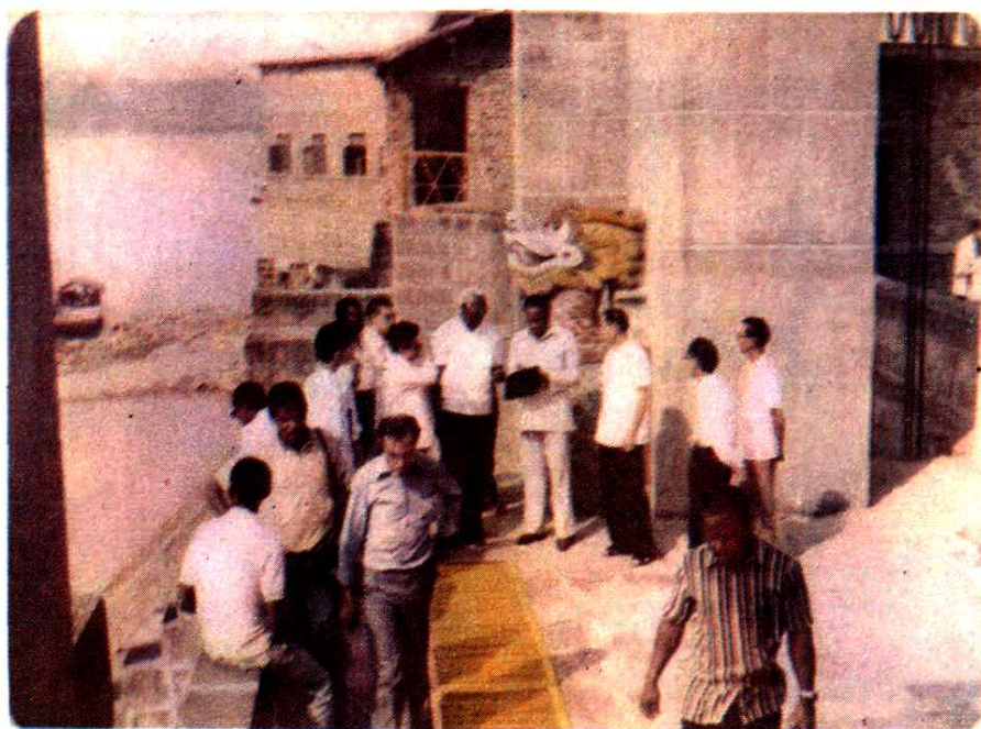
联合国非洲经济委员会能源考察团在黄连沱取水枢纽考察
