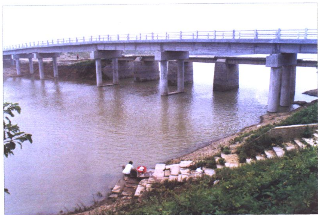
句容河整治中新建的渡桂农桥
