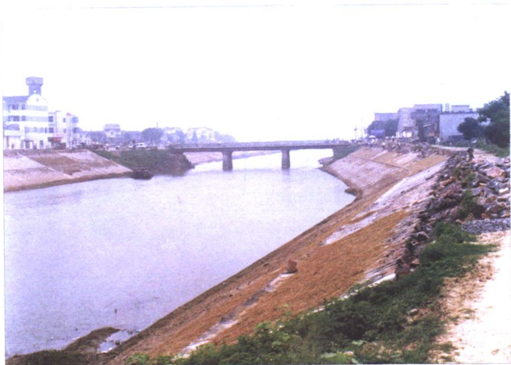
句容河湖熟集镇段护坡工程
