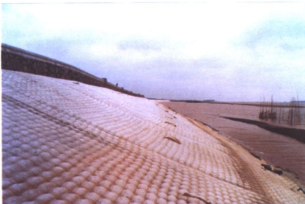
江堤模袋混凝土护坡工程
