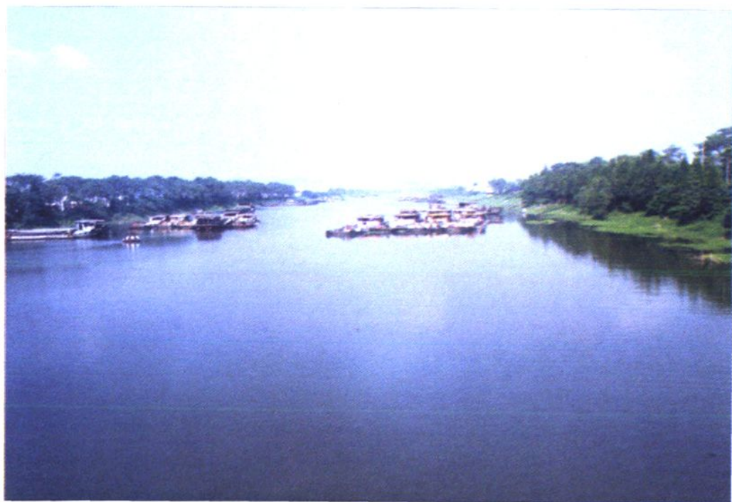
挖成后的秦淮新河河定桥段景观
