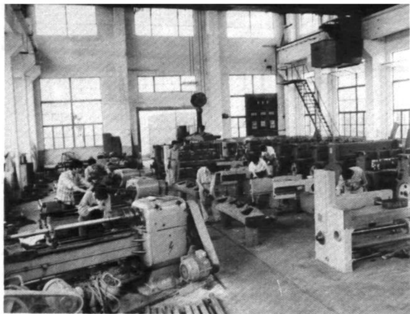
江海机械制造厂车间一角
