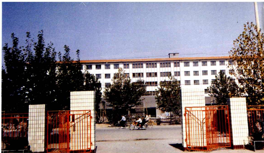
政府办公大楼▶
