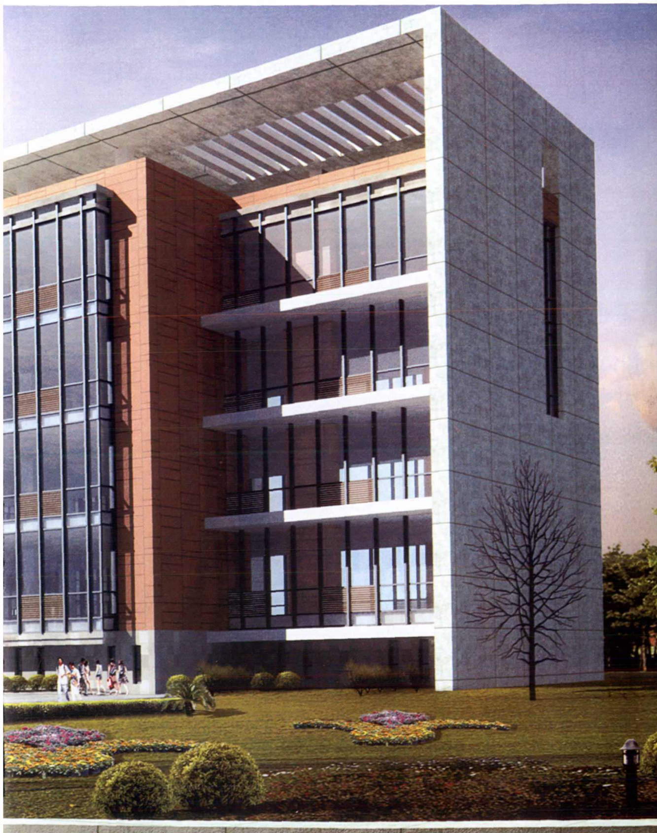
舟山市质量技术监督综合大楼
