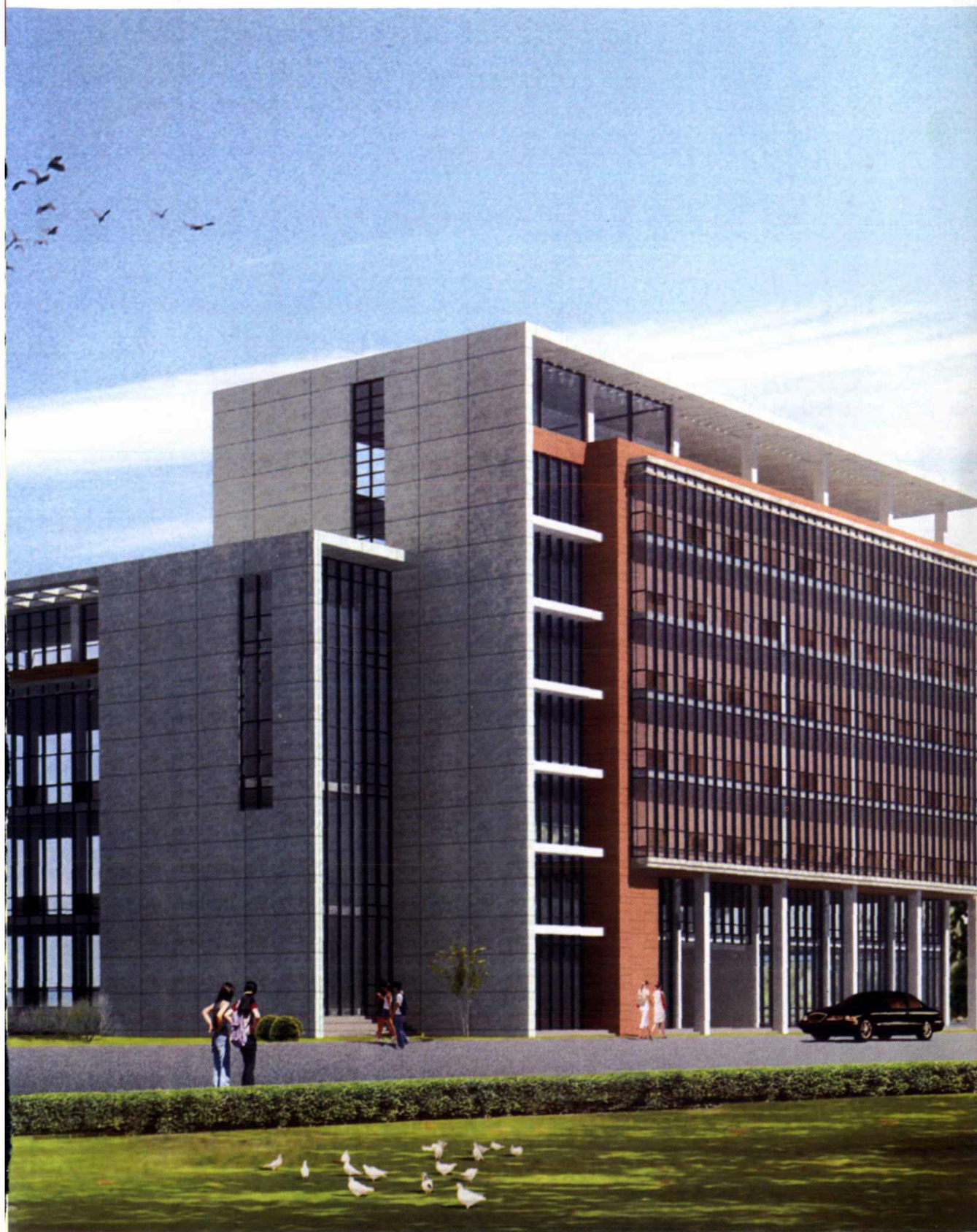
舟山市质量技术监督综合大楼
