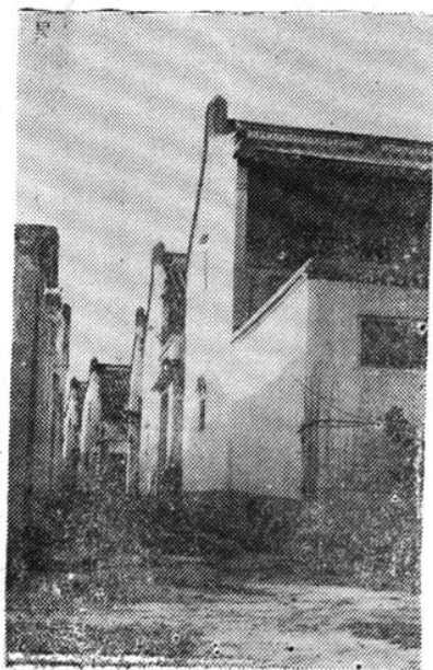
▷ 林泉村新建住宅居楼房一角
