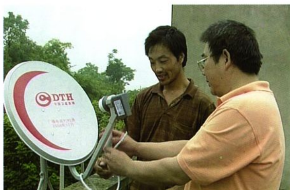
局分管领导指导直播卫星接收设备安装
