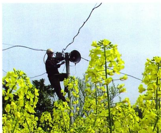
技术人员田间安装广播设备
