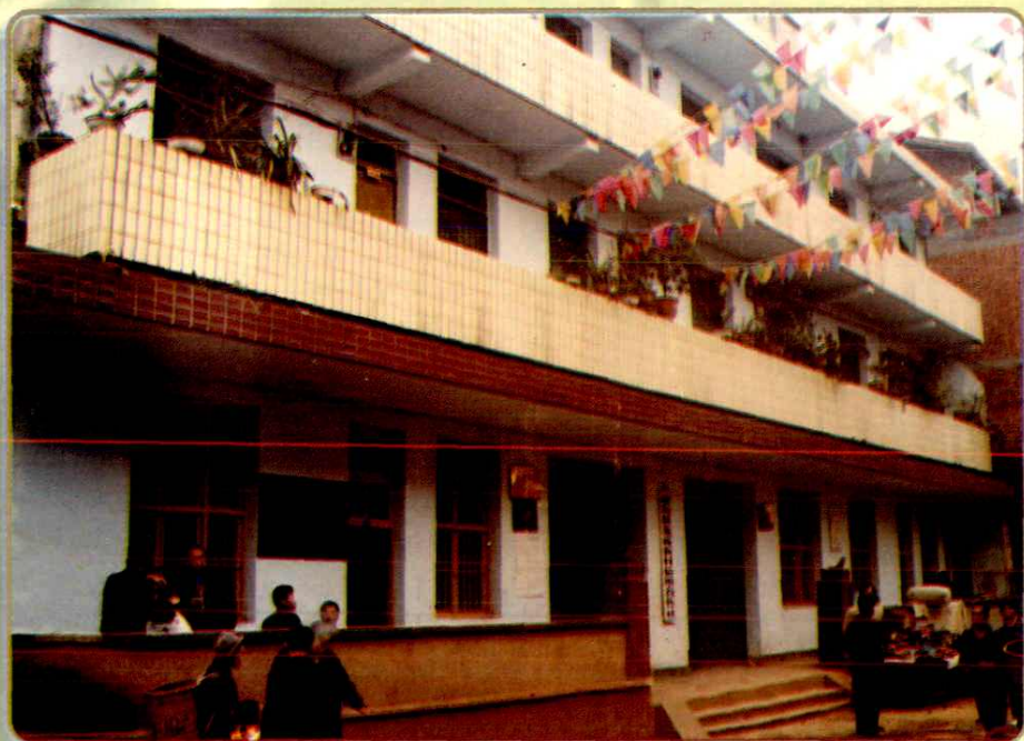
龙孔农村信用社综合办公楼
