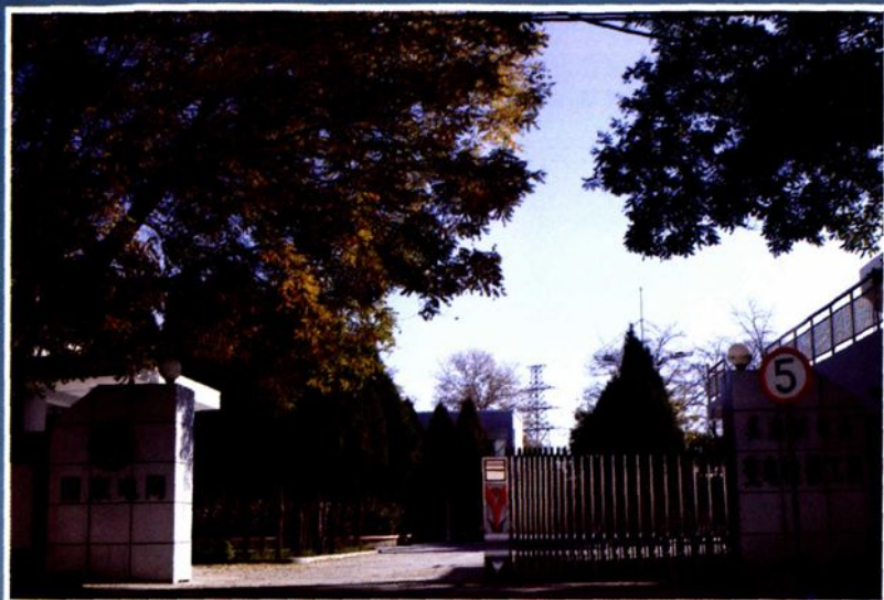
变电检修工区
