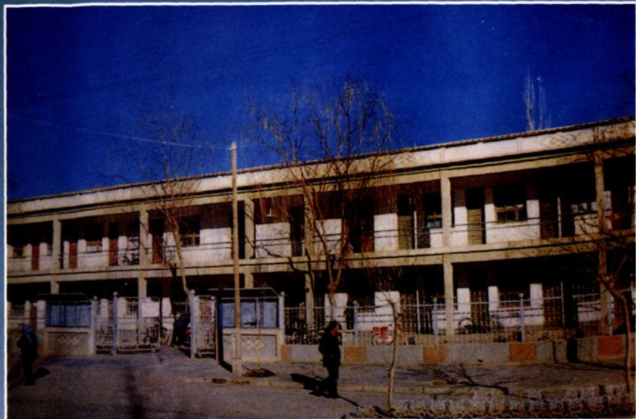
青铜峡市供电局新老办公楼
