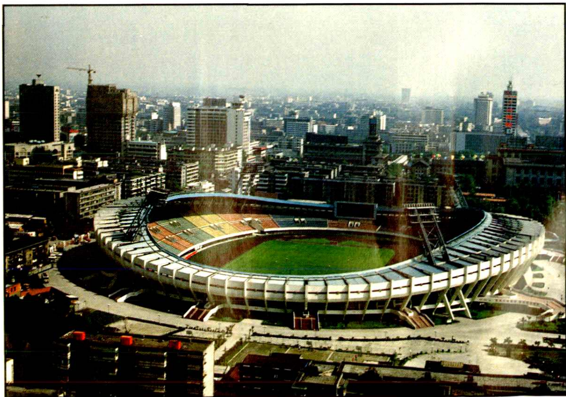
工厂参与施工的成都市体育中心全貌
