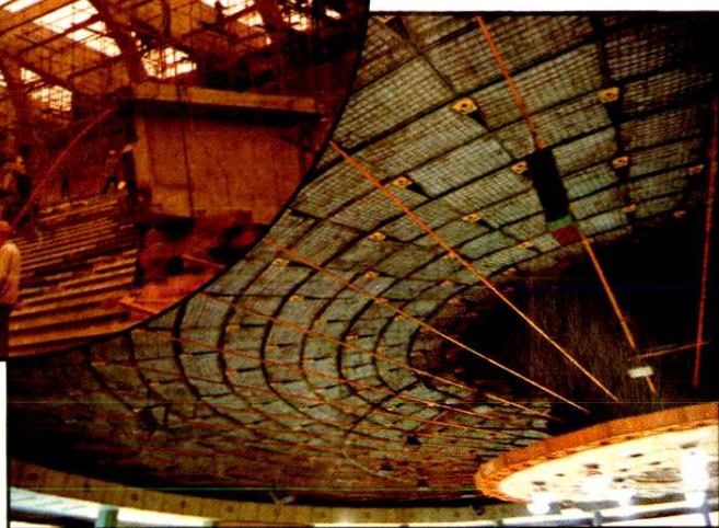
工厂承建的成都市城北体育馆屋顶钢丝悬束
