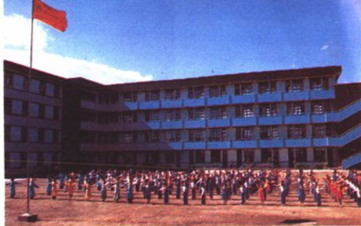
兴安路民族小学教学楼
