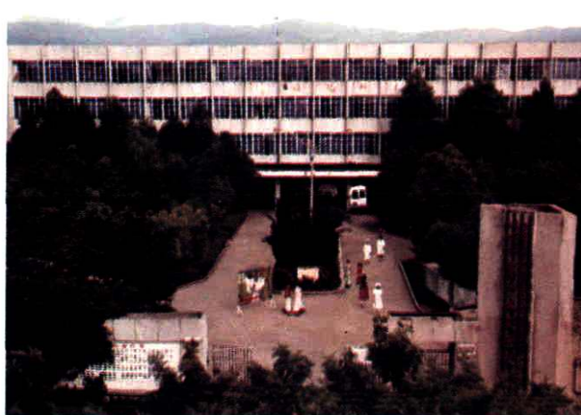
凉山彝族自治州第二人民医院行政大楼
