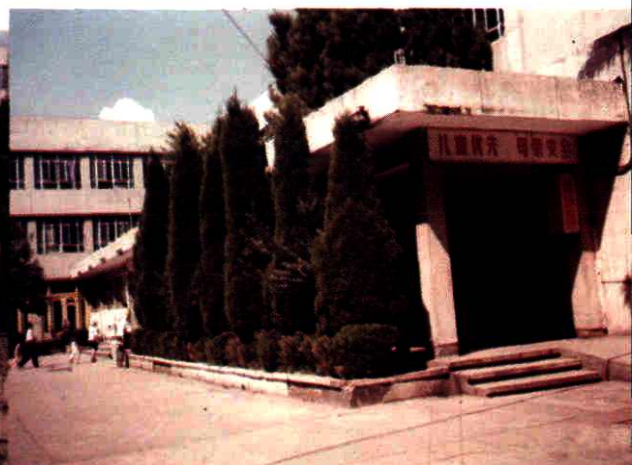
凉山彝族自治州第二人民医院门诊大楼一角
