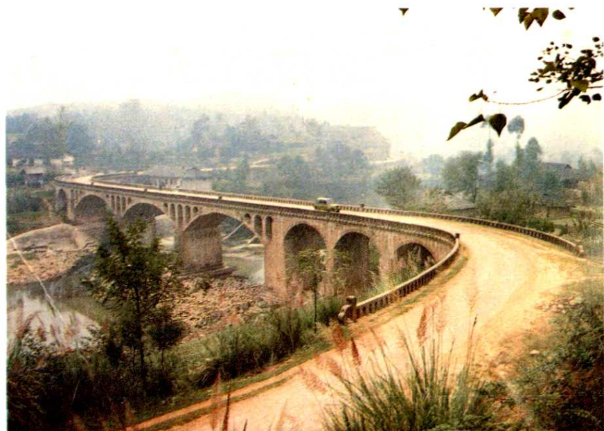
复(兴)新(政)公路龙岗河公路桥
