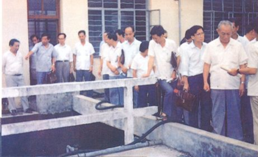
广东省人大主任罗天（右一）和佛山市人民代表视察南海线路板厂的废水治理设施。
