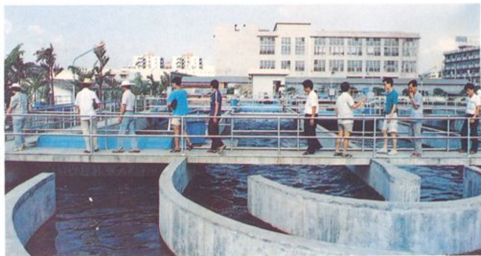
县城的生活污水处理厂。
