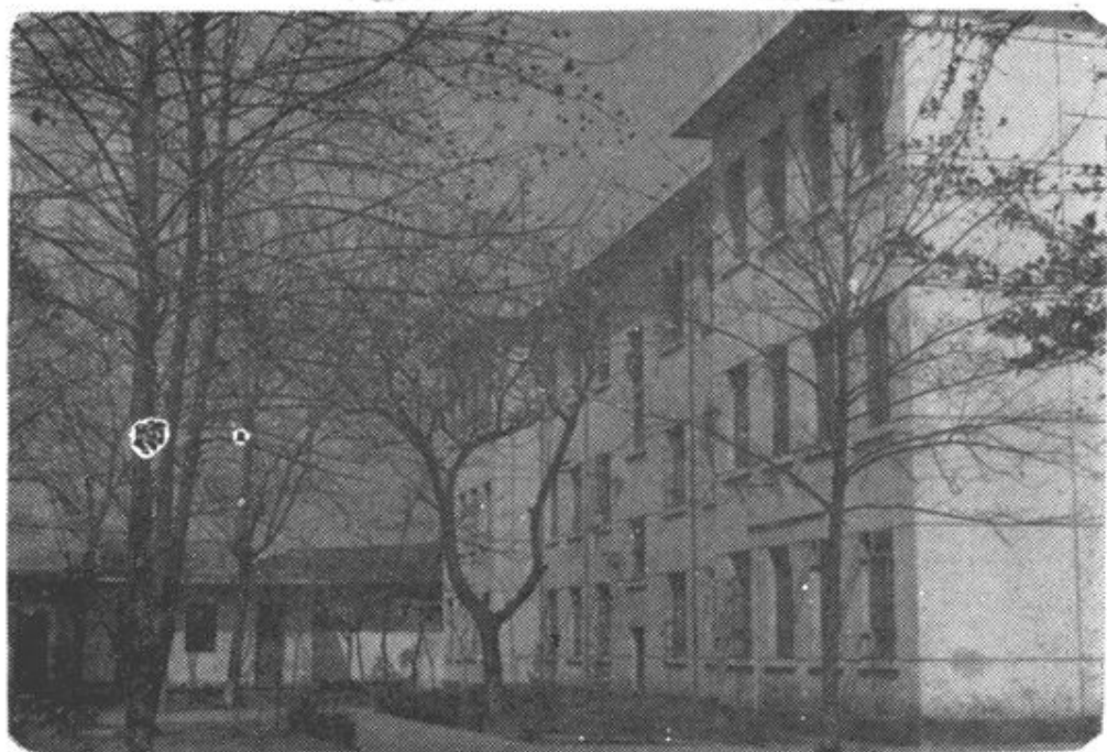
第二教学实验大楼
