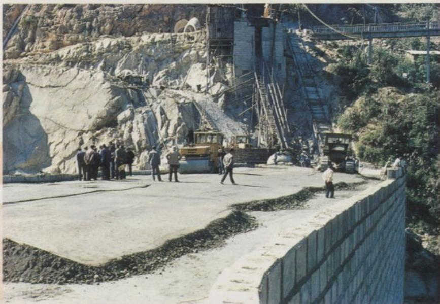
1989年11月, 引进国际先进技术的荣地水电站建设工程, 高频震动碾在拦河大坝上进行混凝土施工碾压。
