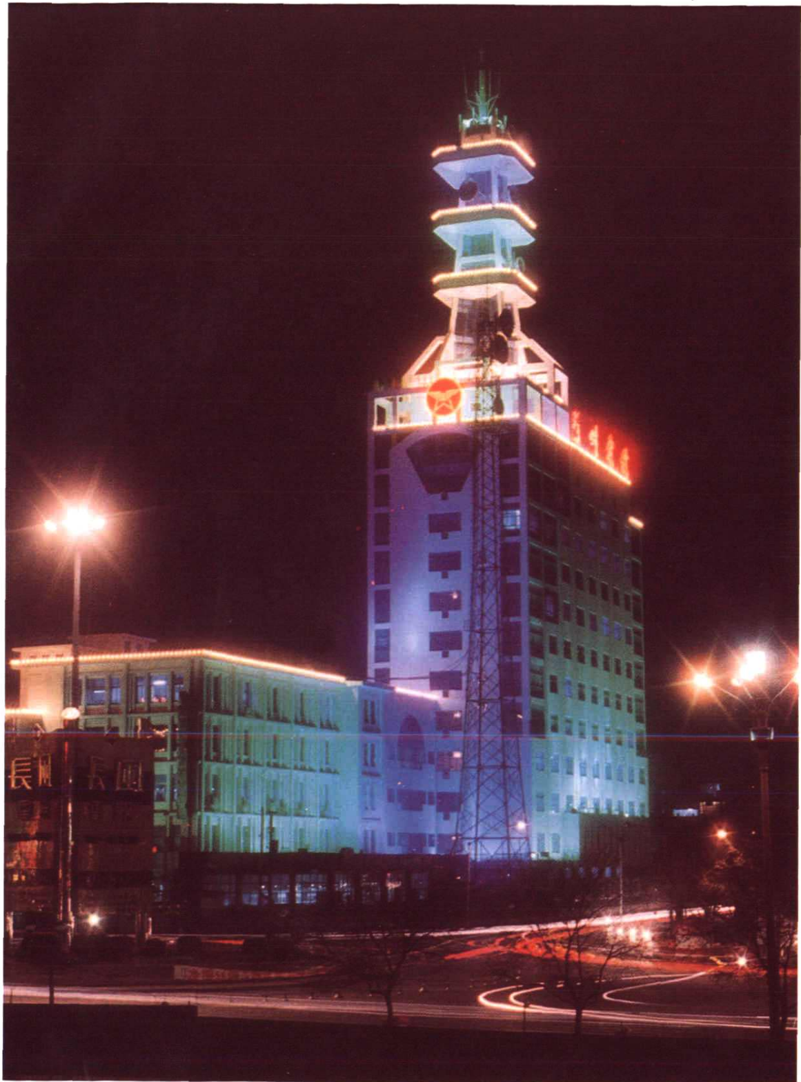
兰州电信枢纽大楼
