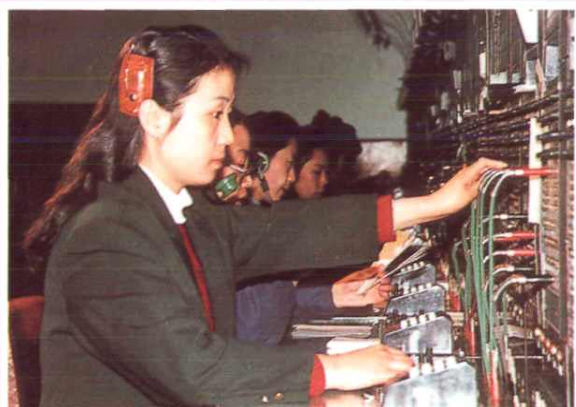
长途人工交换机房(1985 年摄)
