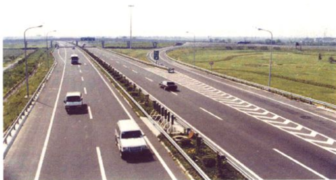
沪宁高速公路昆山站
