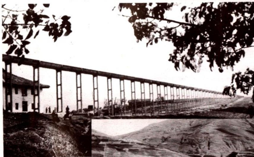
新华水库中河倒虹管
