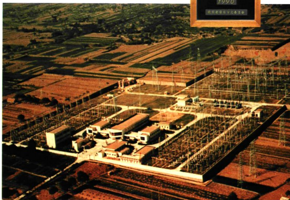
承建河南第一座500kV郑州(小刘)变电站(1988, 国优)
