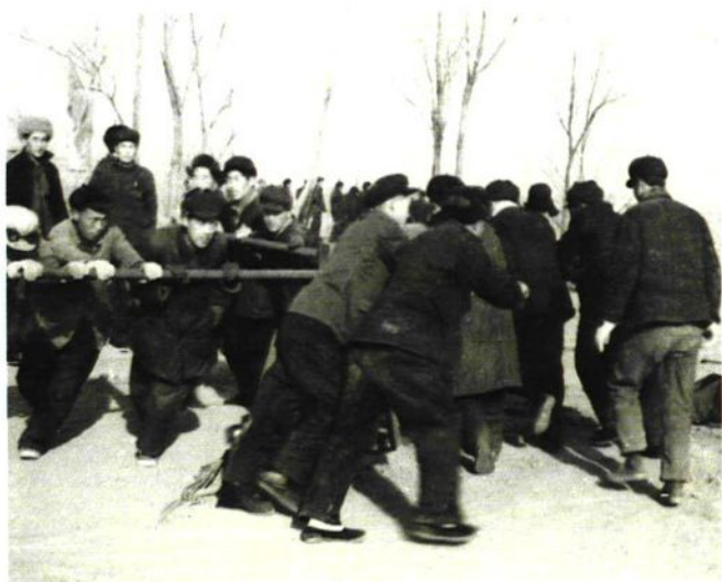
50年代末施工中使用人力绞磨
