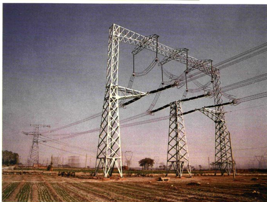
中国第一条500kV 六分裂紧凑型新(乡)— 安(阳)—邯(郸)输电电 路工程(2002)
