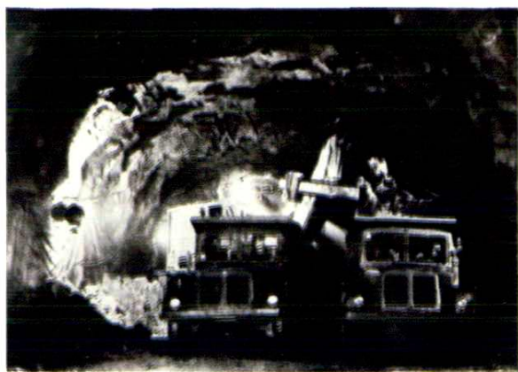
泄流排沙洞施工
