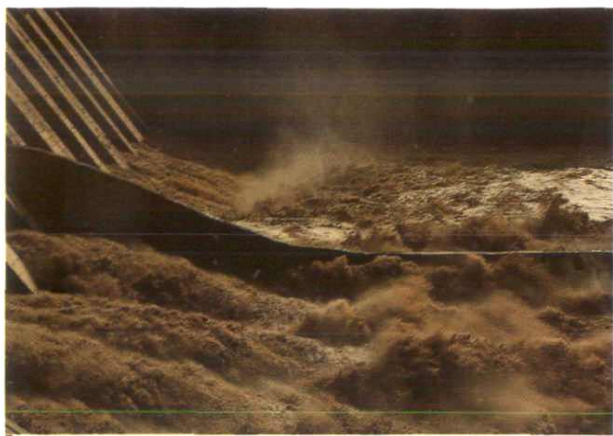
改建后的底孔泄流排沙 (秦军校摄)
