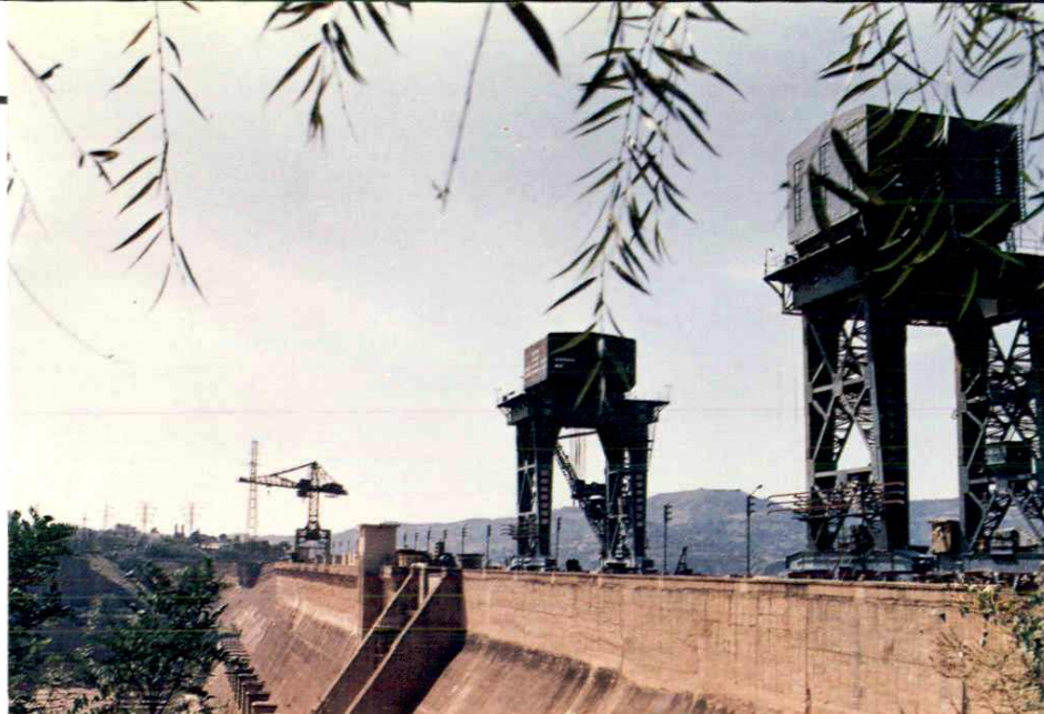
泄流孔闸门启闭设施国产 350 吨门式起重机 (秦军校摄)
