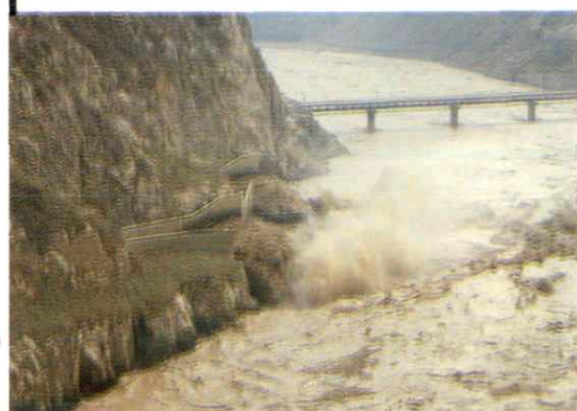
泄流排沙洞运用
