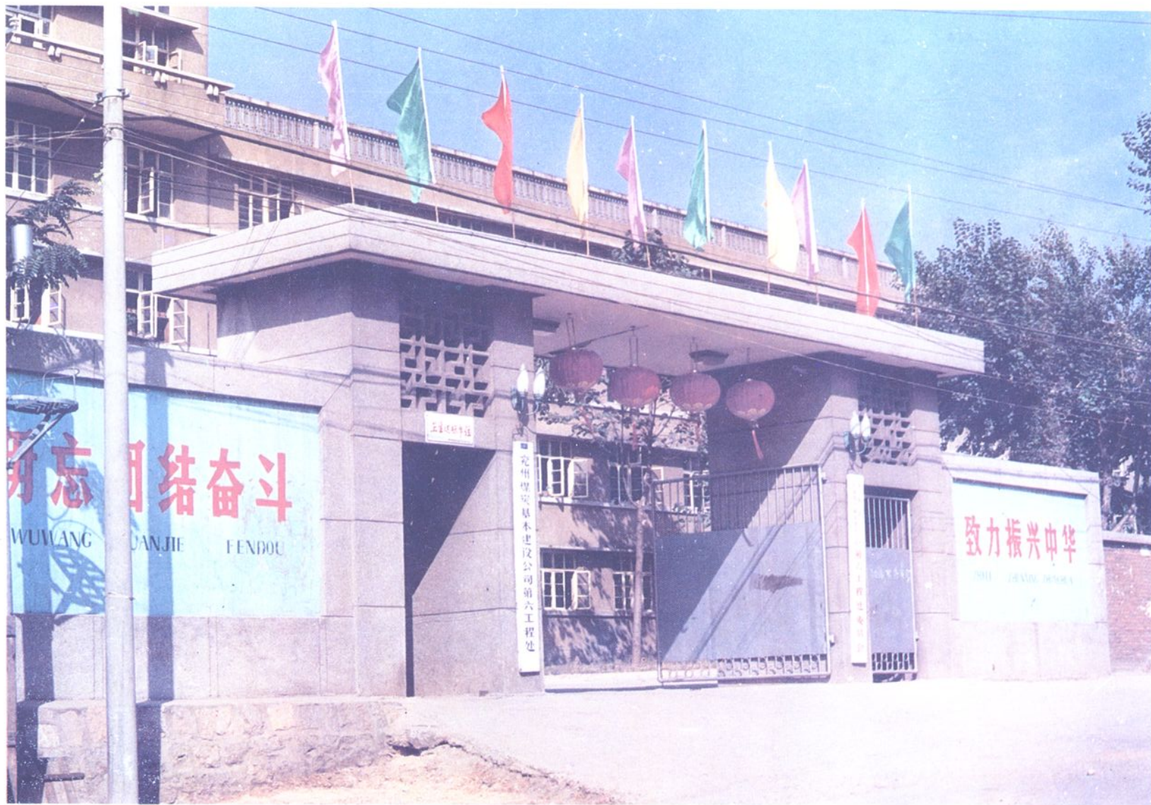
兖州矿务局第六工程处
