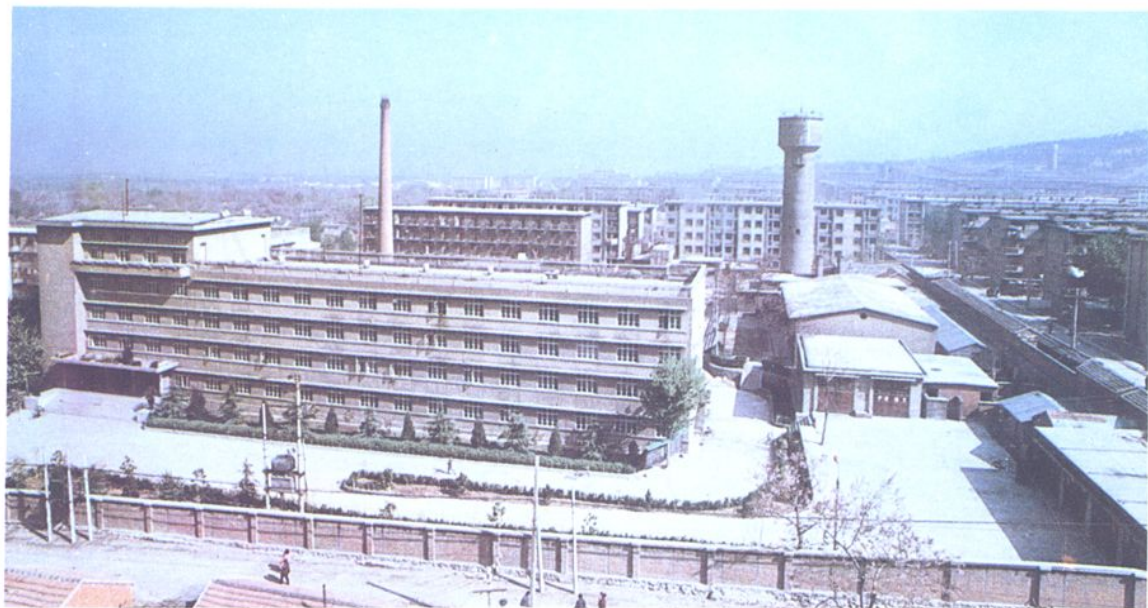
第六工程处办公楼和生活区
