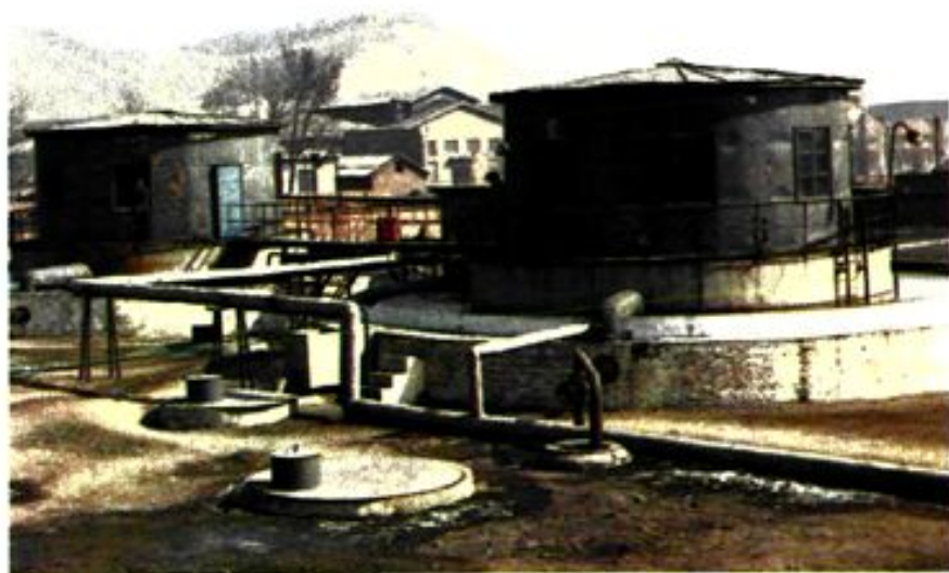
牡丹江炼油厂含油污水处理车间全貌
