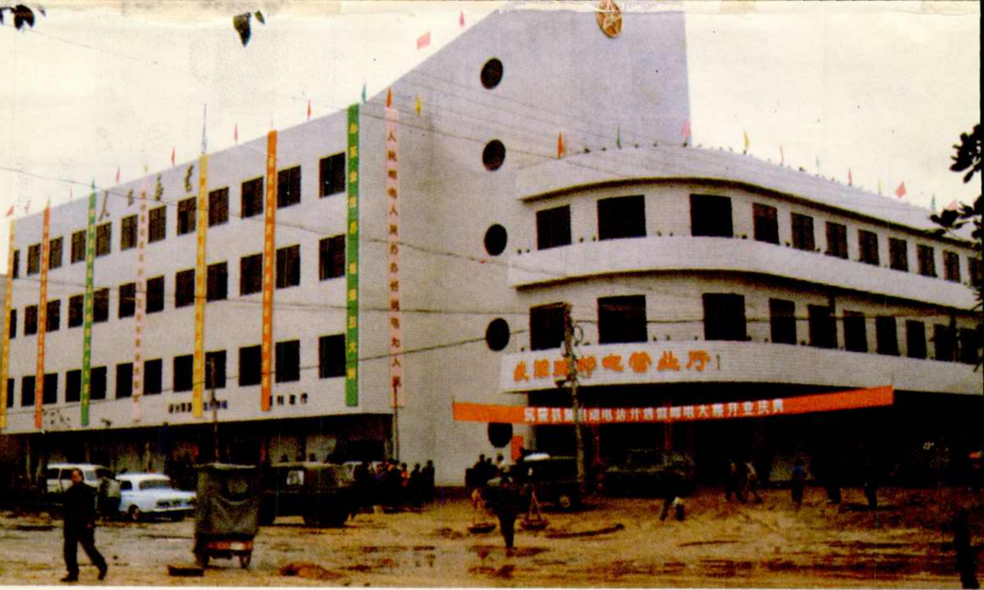
沅陵县邮电局大楼
