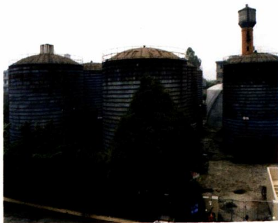
双流县白家粮库油库
