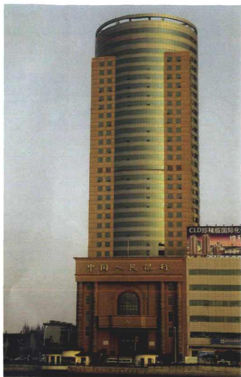
中国人民银行宁波市中心支行大楼 (1999年3月迁入, 江东北路138号)
