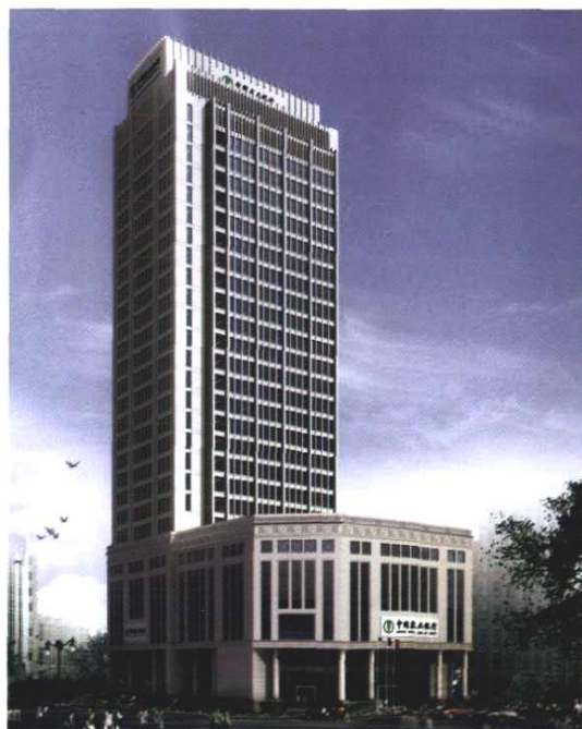
即将竣工的中国农业银行宁波市分行 大楼 (中山东路彩虹路口)
