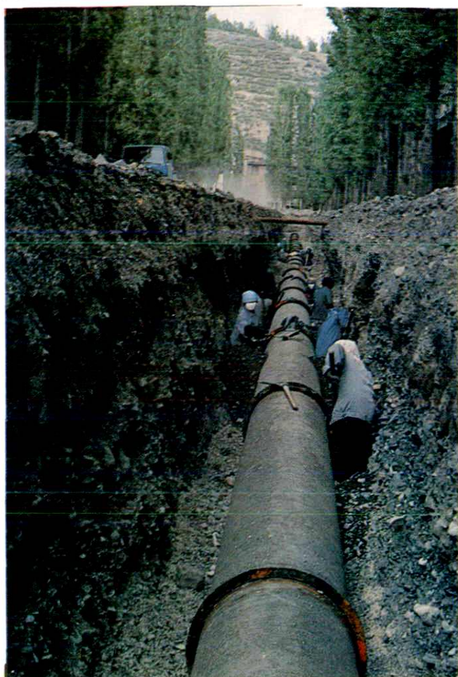
自来水管道安装现场
