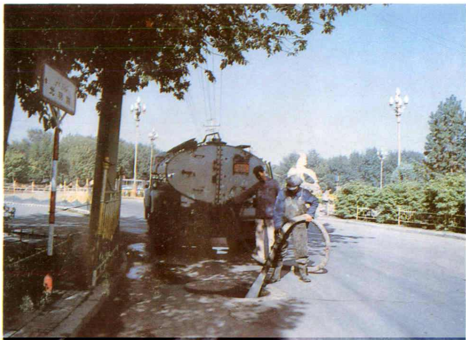
高压水车疏通下水管道
