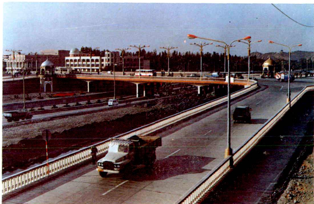
人民路立交桥
