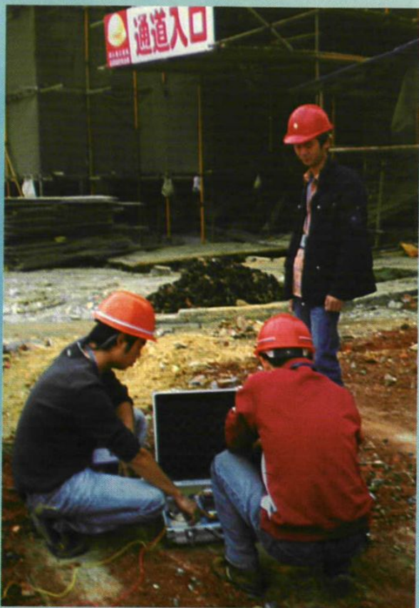
浏阳市气象局防雷检测所技术人员对建筑物进行防雷工程验收
