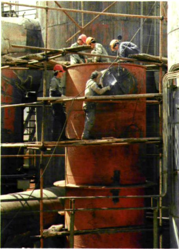
年產值可達500萬元的建築安裝隊施工一景
