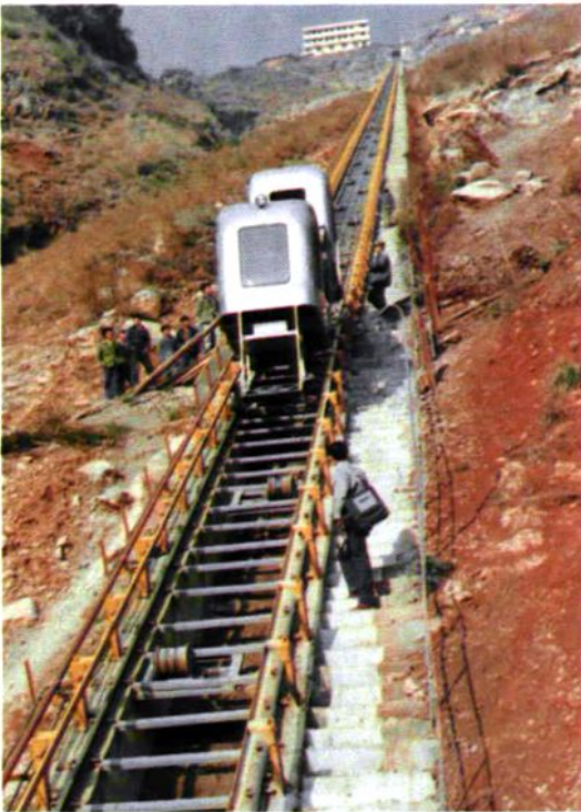
三十四度二十七分的大坡度斜坡捲揚道
