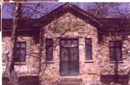
三溪桥邮电所（旧房）
