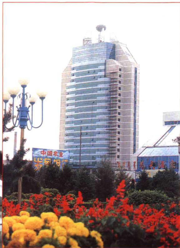
神华集团包头办事处大楼22层， 建筑面积35000平方米
