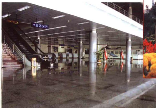
公司承建的包头飞机场工程内景
