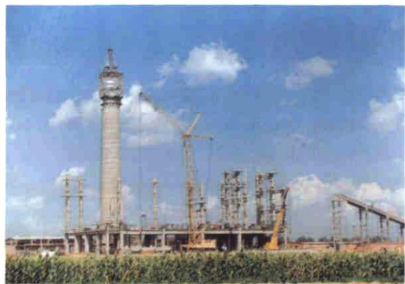
施工中的包头市青东热源厂
