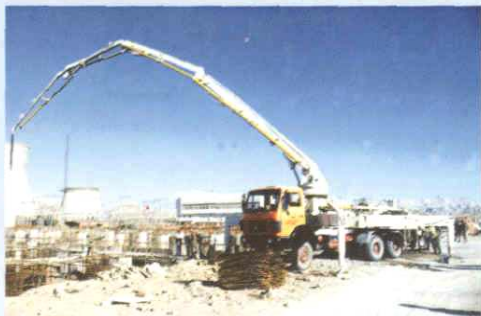
现代化混凝土泵送、搅拌、运输设备
