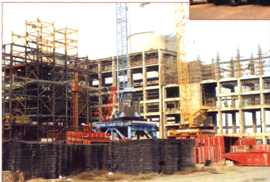
施工中的达拉特电厂3、4号机主厂房
