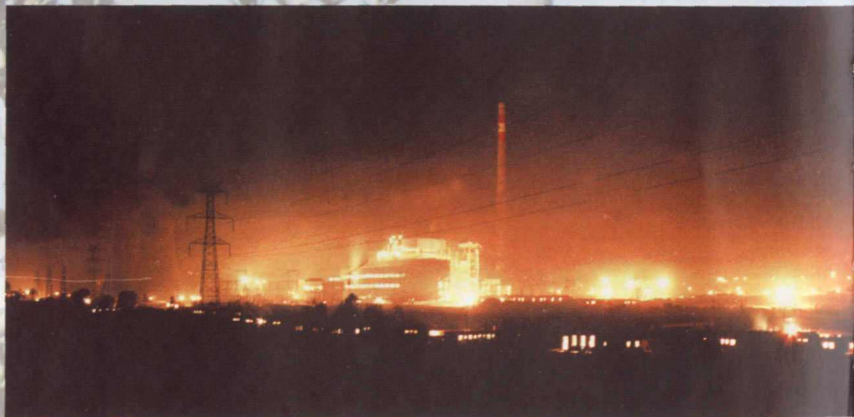
1992年公司承建的内蒙古准格尔2 × 10万千瓦电厂
