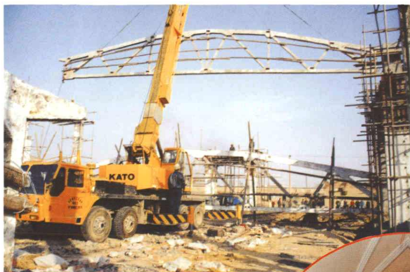
包头市昆都仑国家粮食储备库工程施工过程。
