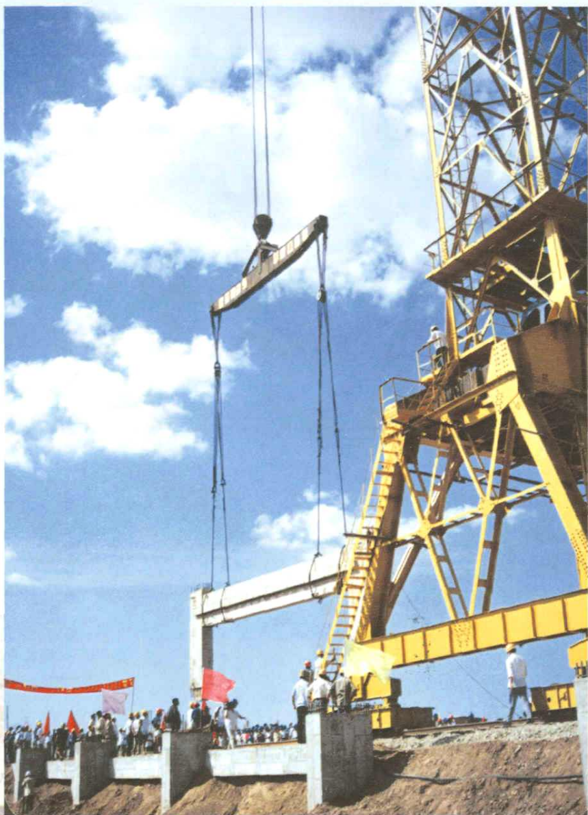
内蒙古准格尔 发电厂主厂房首次 吊装第一钩成功
