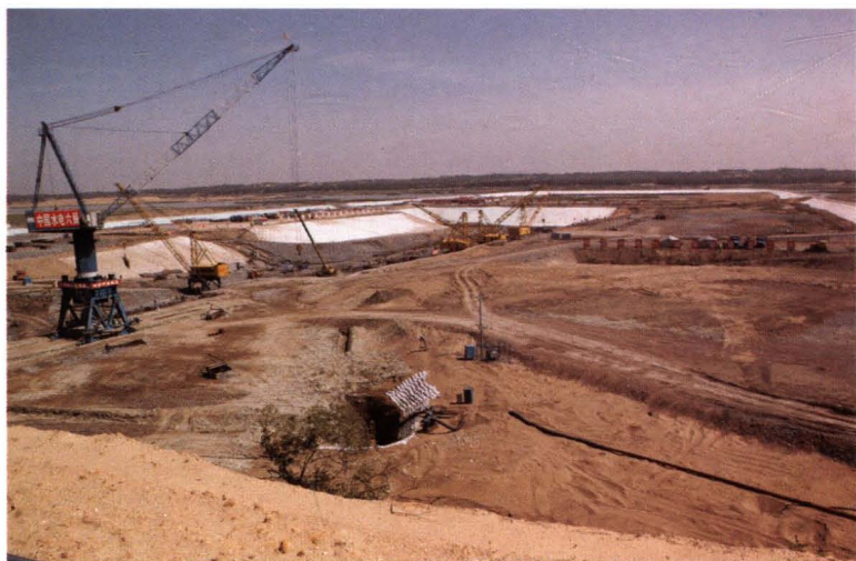
← 建设中的哈达山水利枢纽工程
