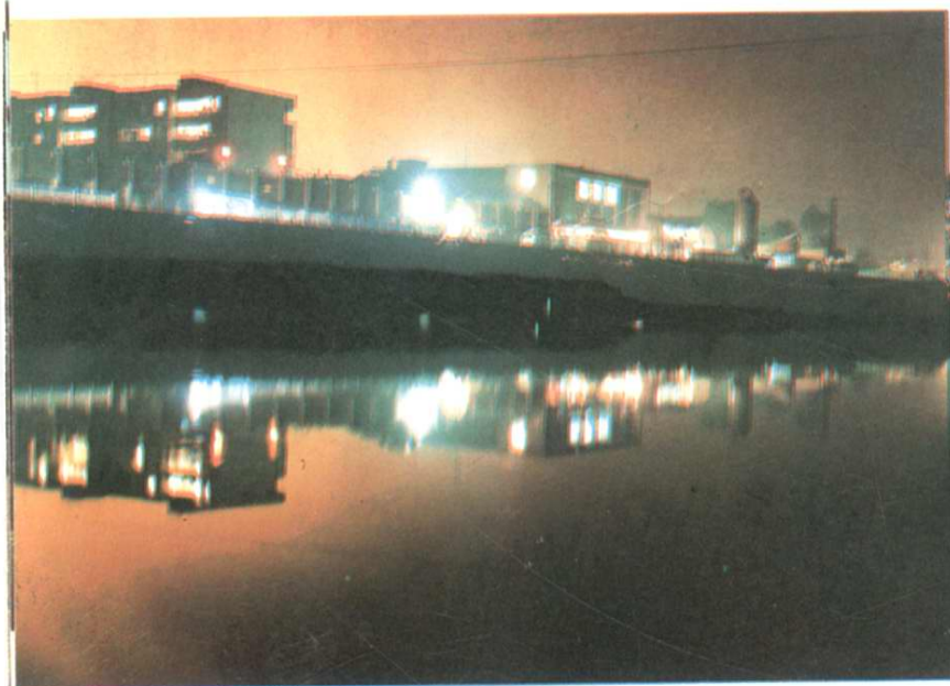
大邑县氮肥厂夜景
