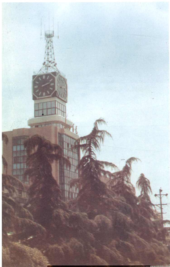
电信综合大楼
