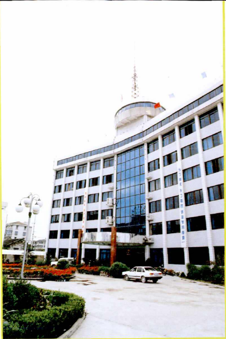
1993 年落成的 供电局电力大楼
