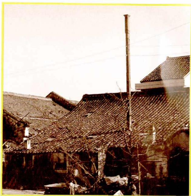
虞宅电厂遗址及方型电杆
