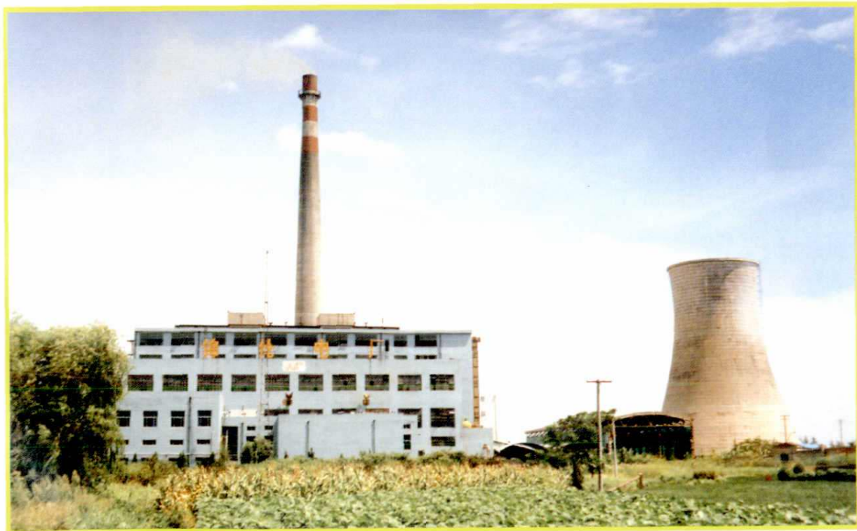
1994年建成的总装机容量为2.55万千瓦的慈溪锦纶热电厂
