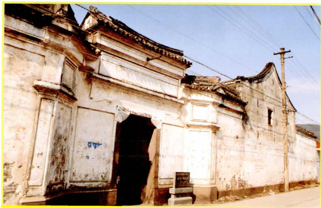
虞洽卿故居前低压线路
