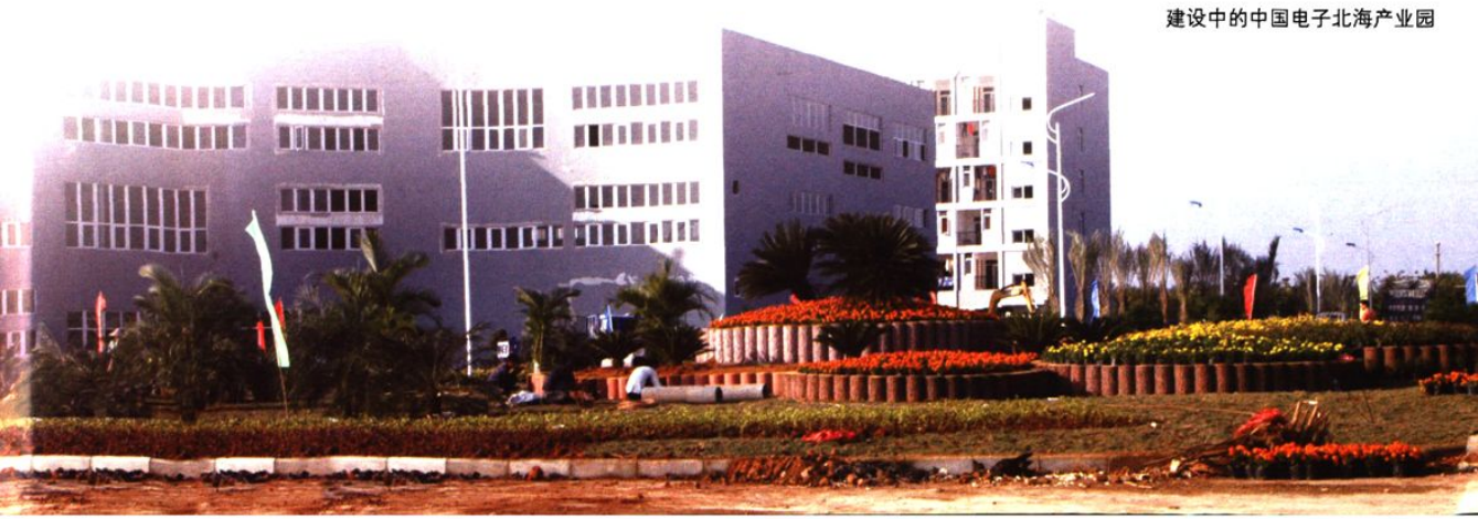
建设中的中国电子北海产业园
